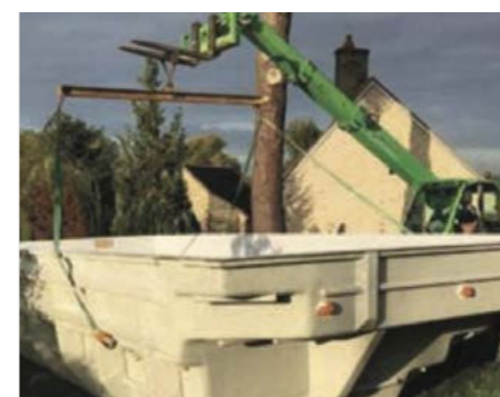
4. Pose en fond de fouille
