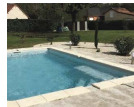
8. Pose des margelles
