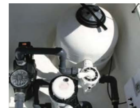
9. Pose du groupe de filtration
